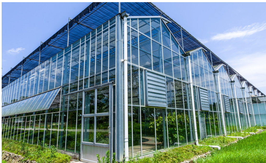
Отопительное оборудование для теплиц, где выращивают овощи и цветы
